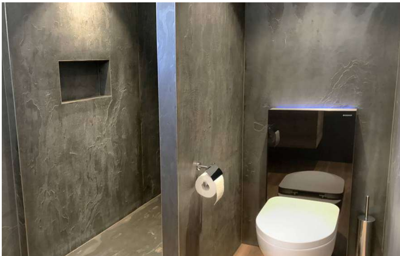
UMBAU BADEZIMMER, GWATT, FIRMA BERNHARD BAUMANAGEMENT GMBH, DEKOR, GOLDEN DROPS
